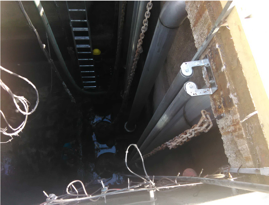
Rinnovamento piping pompe sollevamento V-19
