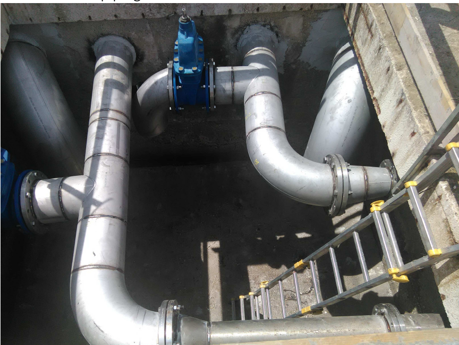
Rinnovamento piping e valvolame camera di manovra V-19
