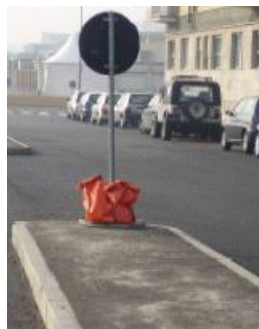
ZAVORRAMENTO PER SEGNALETICA
