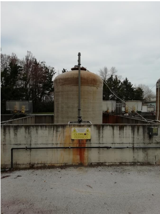
Serbatoio Cloruro Ferrico 40% in peso del Depuratore Falconara Vallechiara (AN)
