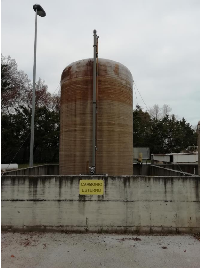
Serbatoio Cloruro Ferrico 40% in peso del Depuratore Falconara Vallechiara (AN)
