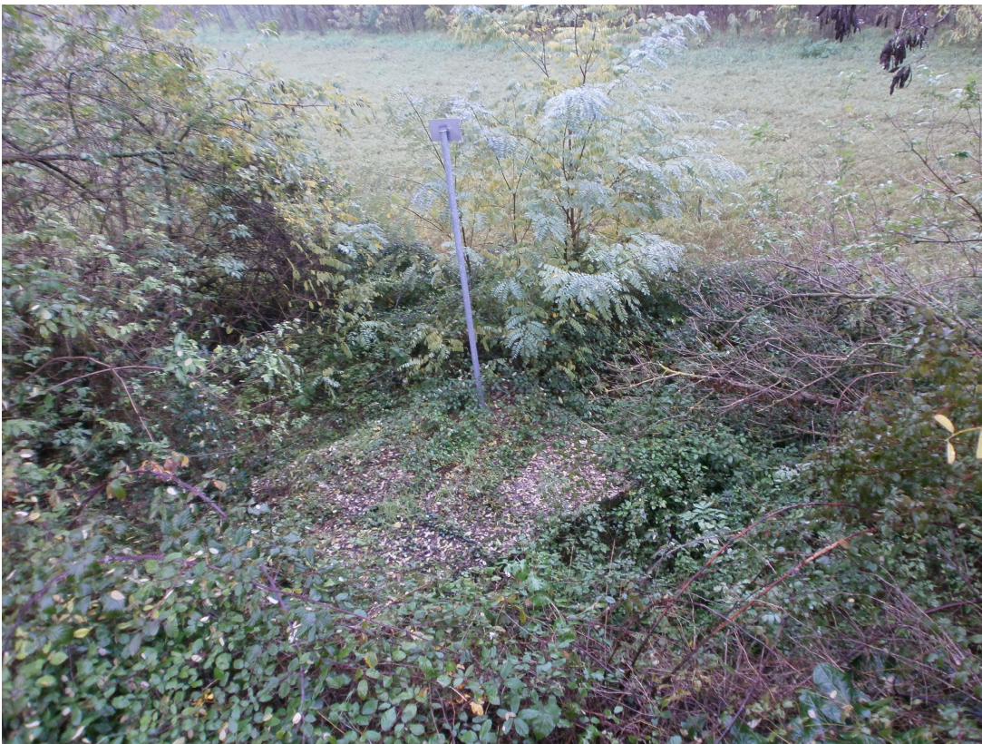
Esempio area esterna pozzetto di acquedotto – Condotta Gorgovivo -
