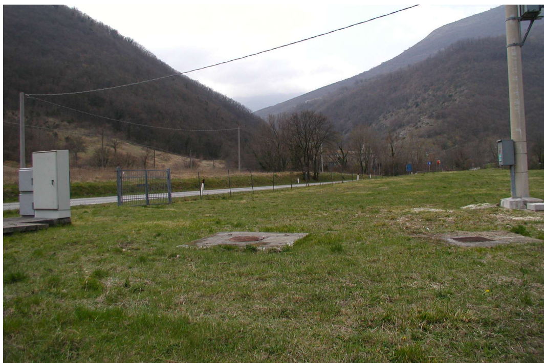
Esempio area esterna complesso acquedotto – Campo pozzi S.Emiliano di Sassoferrato - A-340
