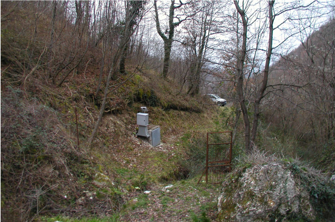
Esempio area esterna complesso acquedotto – Sorgenti del fico di Matelica - A-589
