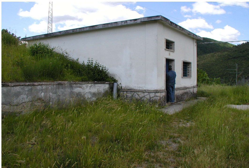
Esempio area esterna complesso acquedotto – Serbatoio Ninno di Fabriano - A-562
